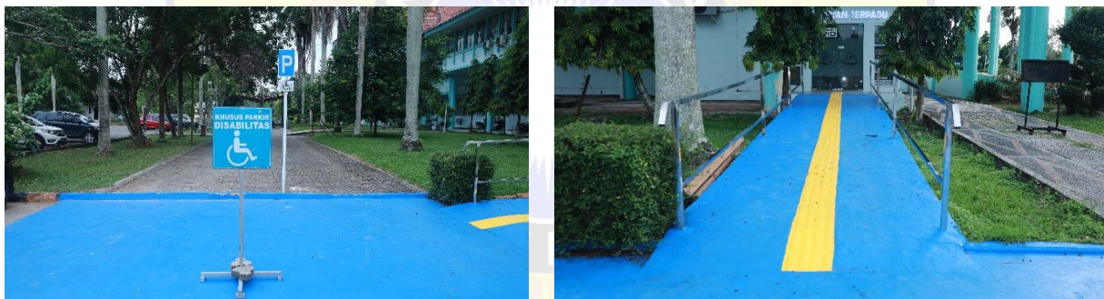
Gambar 4. 27. Fasilitas Disabilitas di Kantor PPID Gedung Rektorat Universitas Sriwijaya
