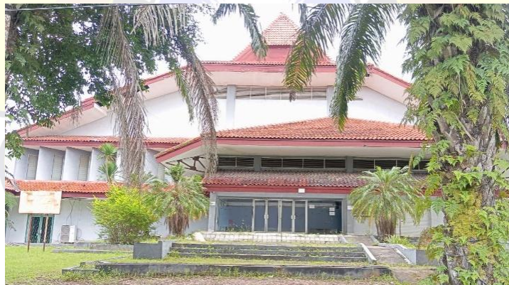
Gambar 4.8. Gedung Teater Universitas Sriwijaya.
